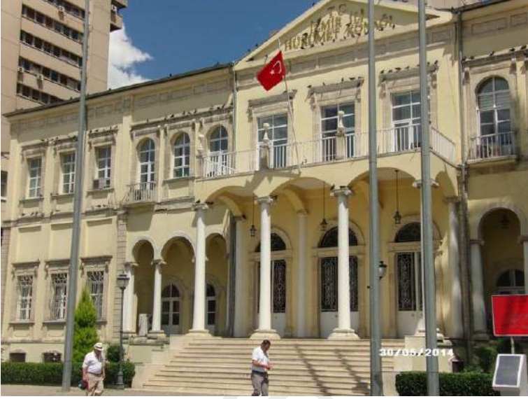
Kırıkkale Hükümet Konağı.
