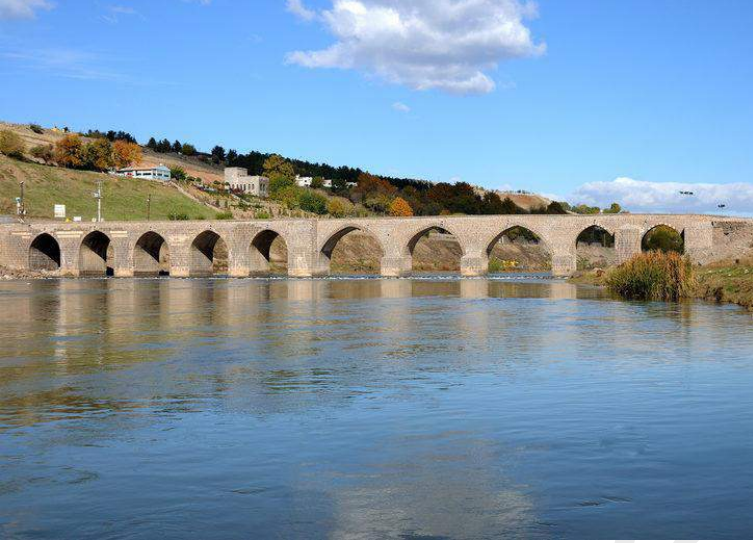
On gözlü köprü
